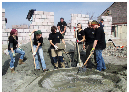
Baueinsatz während einer Gruppenreise in Armenien: Die Teilnehmer mischen Beton für das neue Haus.
