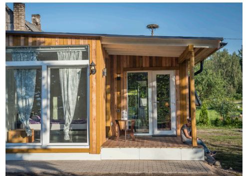
Containerausbau: ein fehlendes Badezimmer oder Küche lässt sich leicht in einen Seecontainer einbauen und ans Haus dranstellen.
