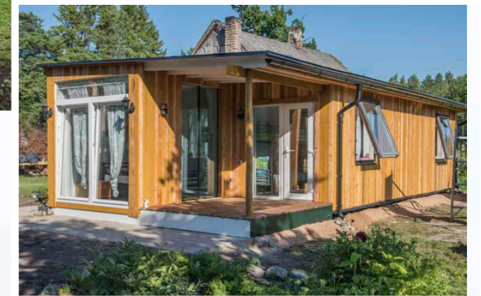
Aus zwei Containern wurde in fünf Tagen ein neues Zuhause.
