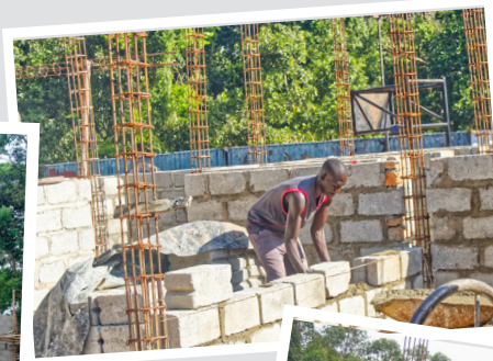
Hier entsteht das neue Bürogebäude mit Restaurant.
